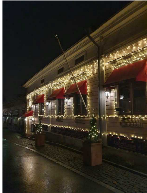
Kuva 49. Ravintola Trappin kausivalaistus.
