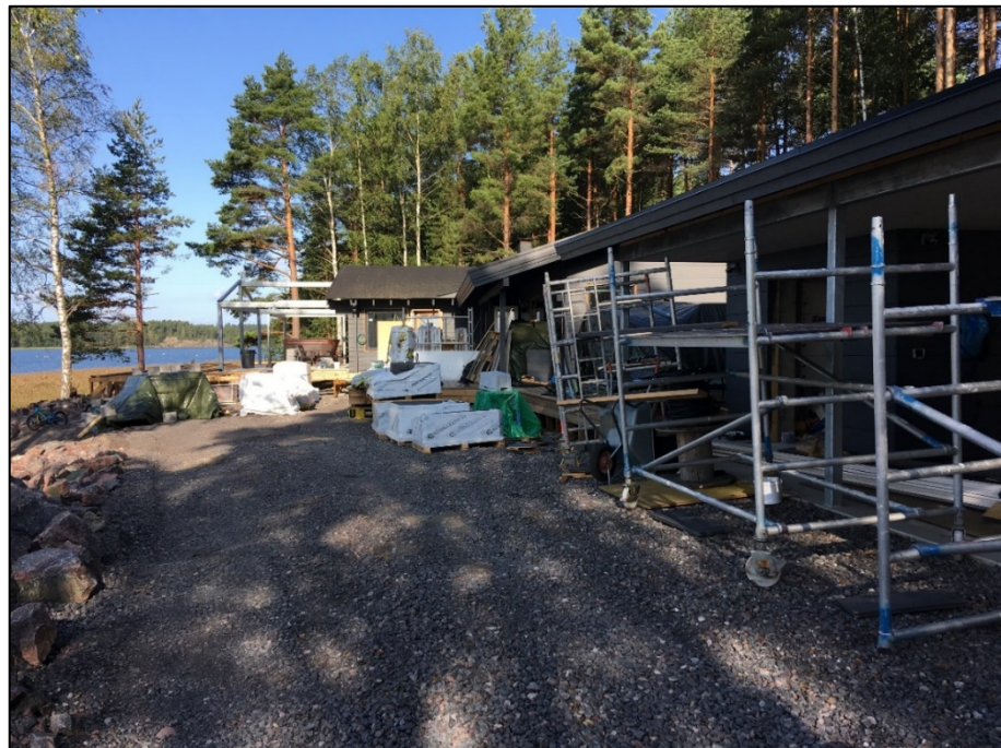
Rakenteilla oleva loma-asunto ja sauna korttelissa 9. Etualalla erillinen autokatos. Kuva: Pasi Lappalainen
