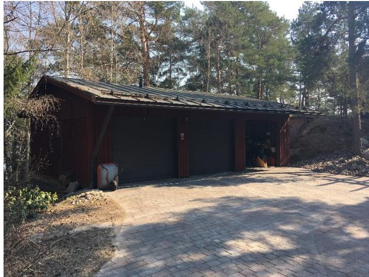
Suunnittelualueella sijaitseva talousrakennus. Kuva: Pasi Lappalainen
