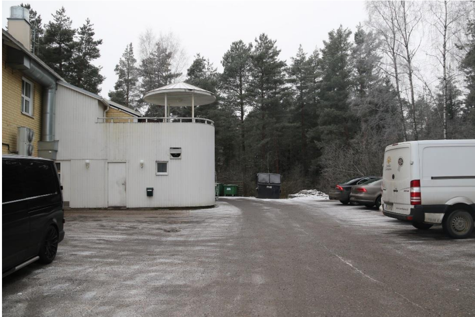
Ruotupihan tuleva katulinjan kohta kuvattuna länteen.
