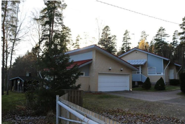
Lossintien eteläpuolen rakennuskantaa.
