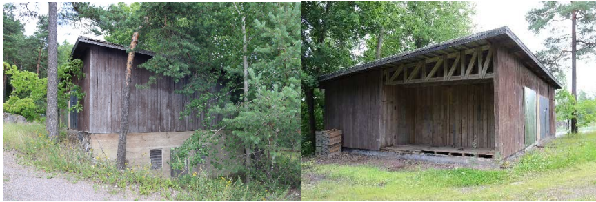
Varastorakennus noin 1940-luvulta, Kaivolan tila 529-412-1-19.
