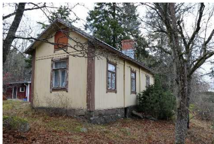
Yli-Kaivolon torppa pihasaunan rakennus- alalta kuvattuna.
