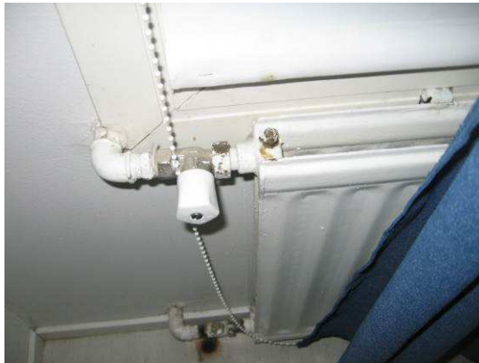
Käsisäätöinen patteriventtiili
