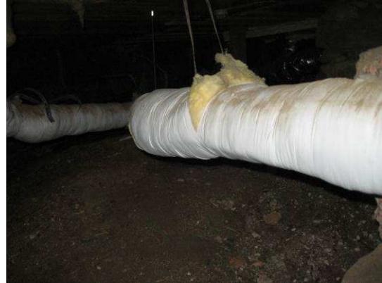
Viemäriputkien lämpöeristystä pohjakerroksen ryömintätilassa
