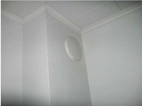
Rakenneainekanaava huoneessa
