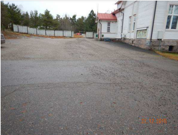
Halkeilua asfalttipinnalla.
