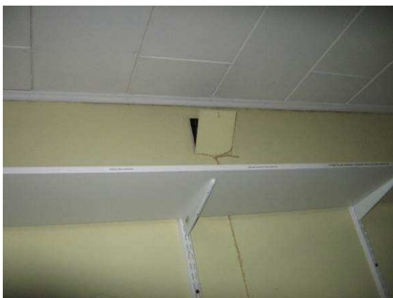
Vanha huonokuntoinen venttiili
