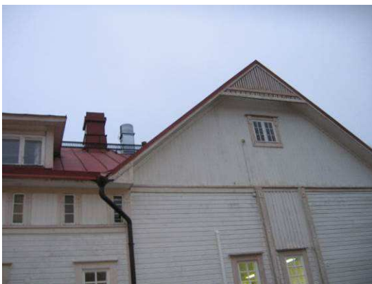
Uudehko poistoilmamuri vesikatolla
