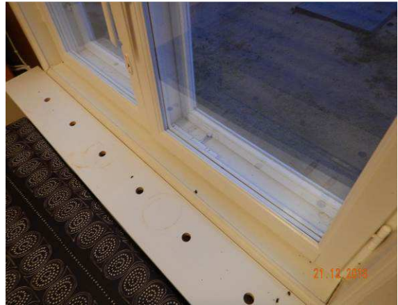
Uusittu ikkuna sisäpuolelta.
