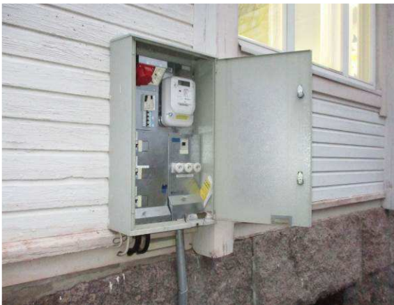
Talovarokekotelo ja kiinteistön mittaus.
