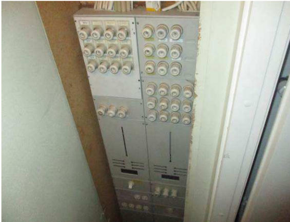
Sähköpää- ja kiinteistökeskus.
