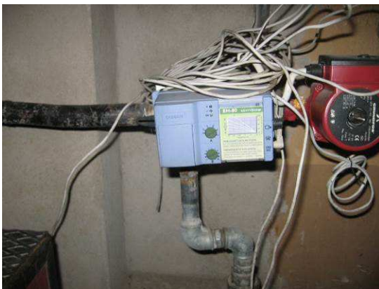
Lämmitysverkoston lämpötilasäädin
