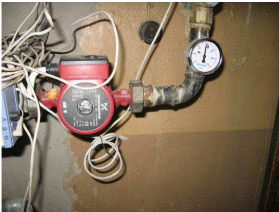
Lämmitysverkoston kiertovesipumppu
