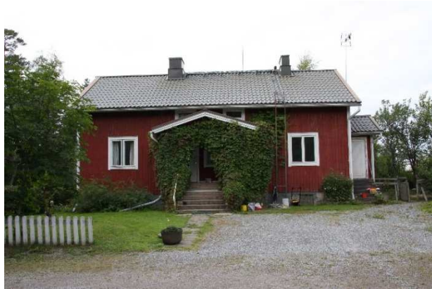
Purettava rakennus Mauste-Sallisen tulevan laajennuksen kohdalla kiinteistöllä 529-8-17-4. Ks myös liite 11.
