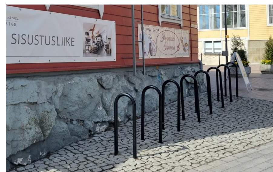
Kapeita kaaritelineitä Naantalin vanhassa kaupungissa. Huom. Näissä telineväli todennäköisesti alle 1,0 m, jolloin kaikki paikat ei ole aina käytettävissä.
