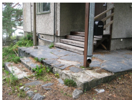
Eteläpäädyn sisäänkäynti. (Kuvat aln 2023)
