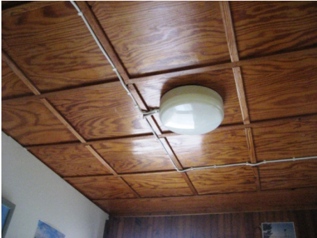
Pohjoispäädyn huonetiloja ja sisäkatto (Kuva aln 2023).
