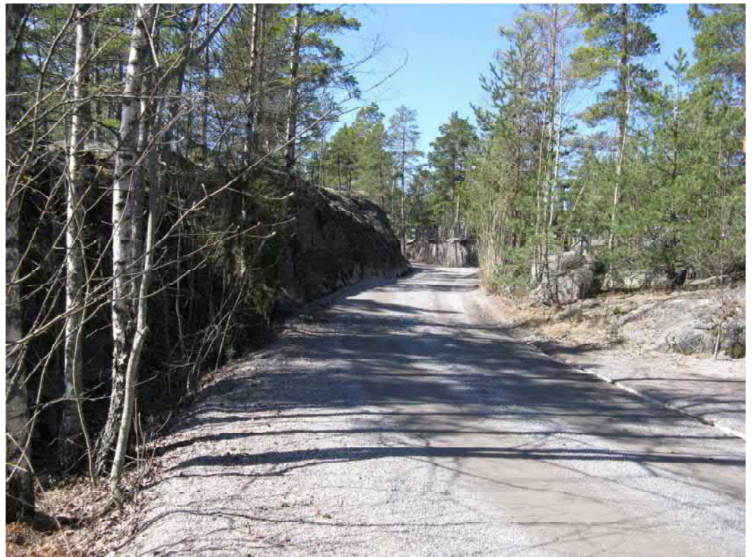
Kuva 6: Herrankukkarontie on linjattu onnistuneesti kallioseinämän kupeeseen
