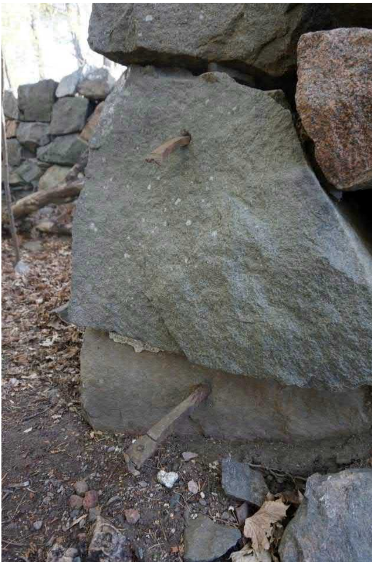
SKDG202202:40. Yksityiskohta eteläisen oviaukon itäreunasta, jossa on kaksi tukirautaa ja kivien välissä laastia.
