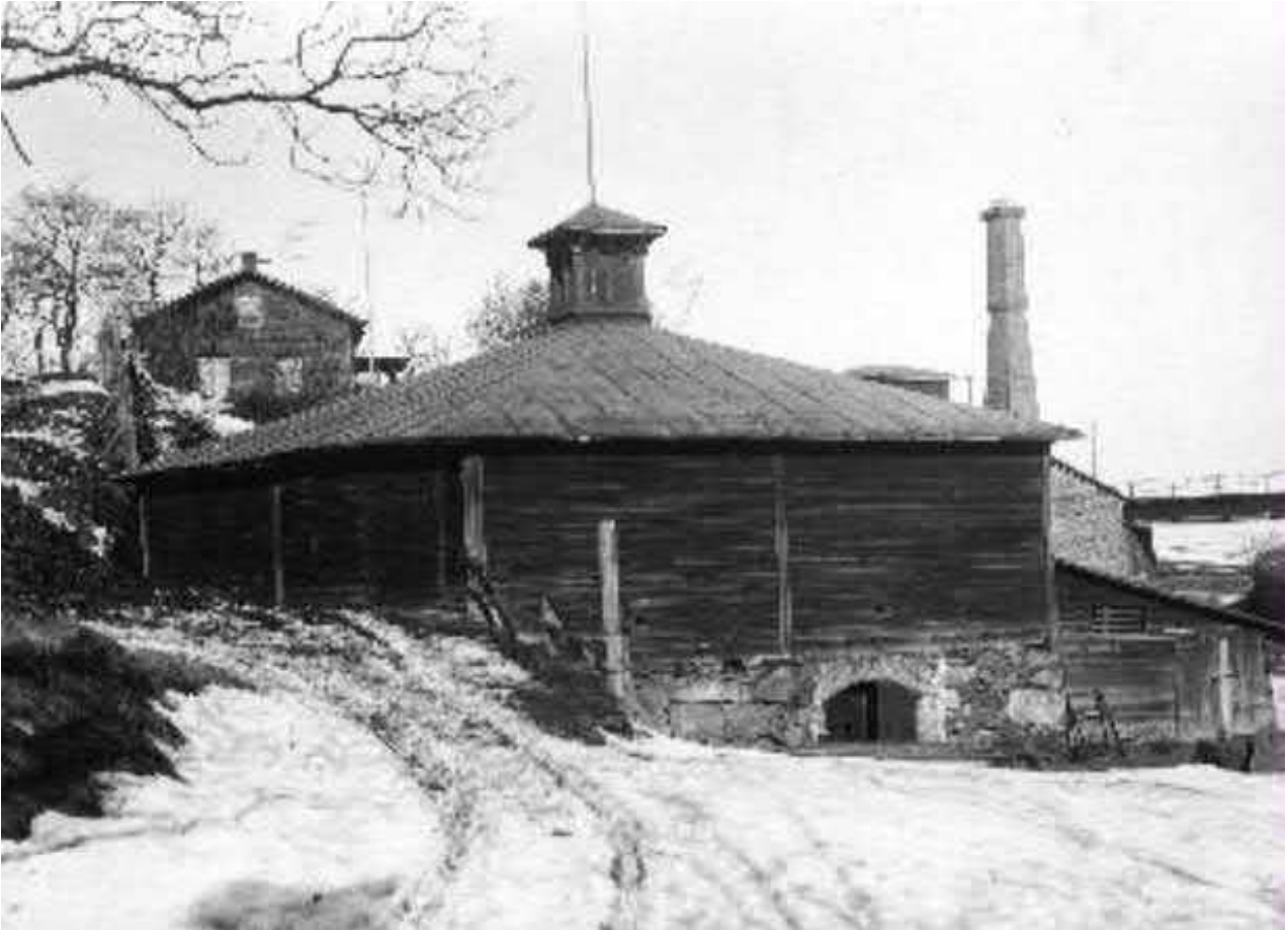
Tampereen Kuninkaankadun viinapolttimon kellari vuonna 1928. Sen kivi- ja tiilirakenne näyttäisi hyvin vastaavan Viluluodon ison kivijalan rakennetta leveine oviaukkoineen. Kuva Museokeskus Vapriikki HM1232:3, Finna.
