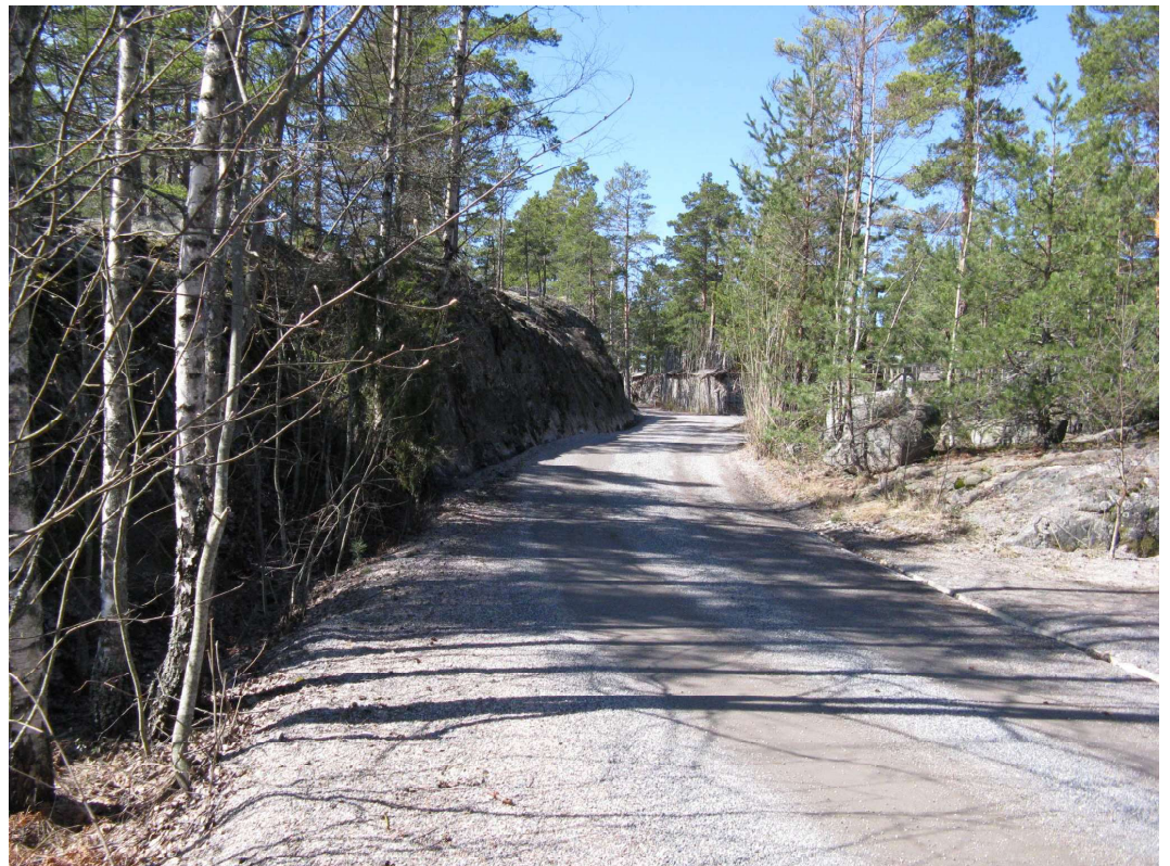
Kuva 6: Herrankukkarontie on linjattu onnistuneesti kallioseinämän kupeeseen
