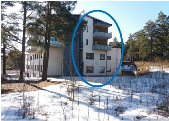
Päätyikkunoiden eteen on jätettävä tilaa
