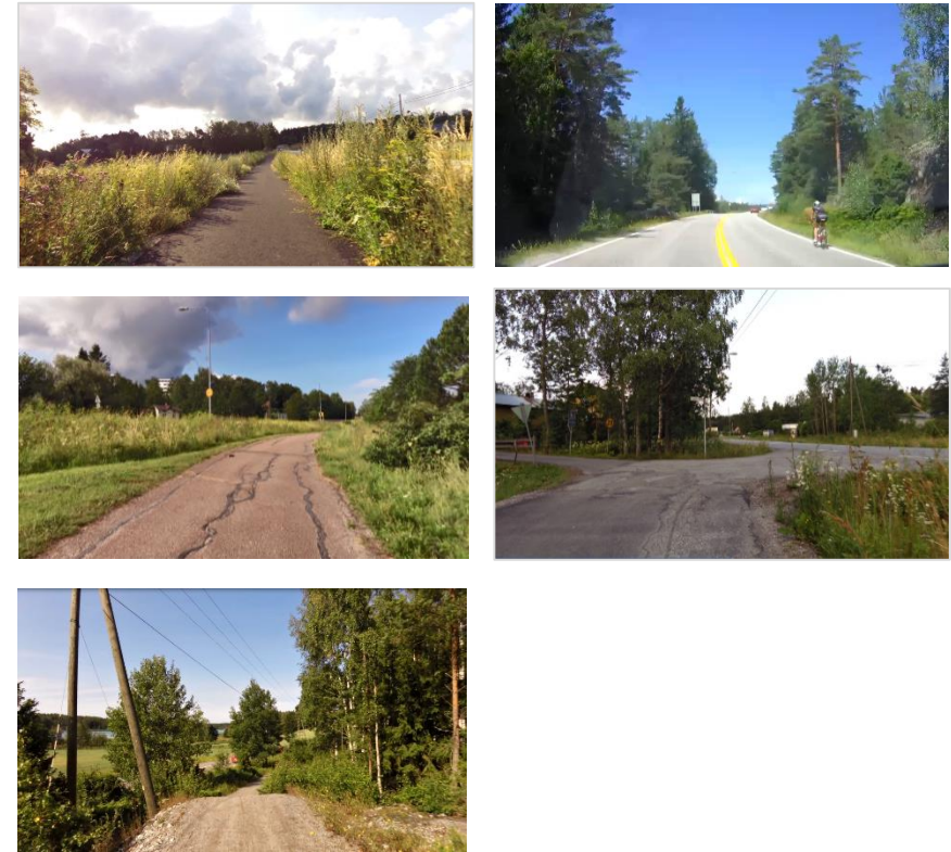
Kuva 13. Maastoinventoinnissa havaittuja puutteita.
